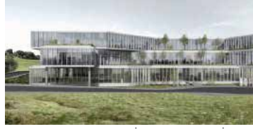
METAL YAPI KEMERLİFE 23 PROJESİ
