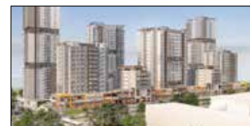
CİHAN İNŞAAT AVRUPARK BAHÇEŞEHİR
